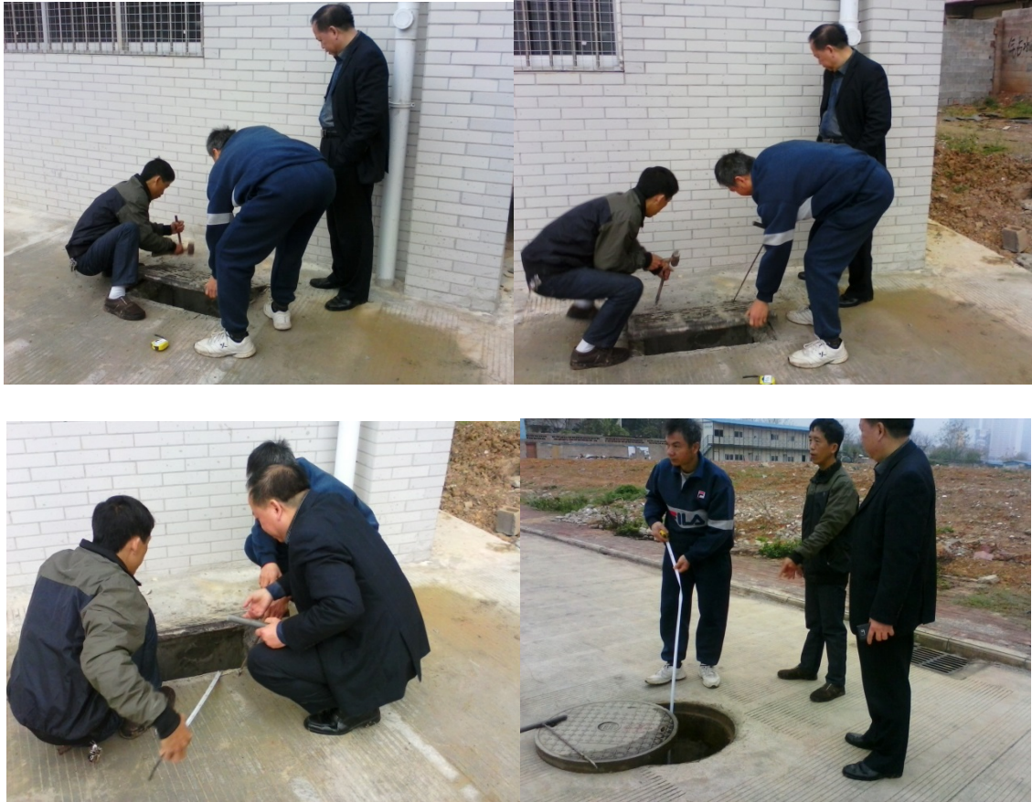
李仕钦副院长就东楼排污改造方案进行现场指导
